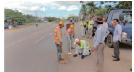
案件化調査 カンボジアで、交通事故の原因にもなり得る道路の損傷を日本の中小企業の技術で補修する
