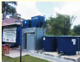
村に設置された浄水装置
